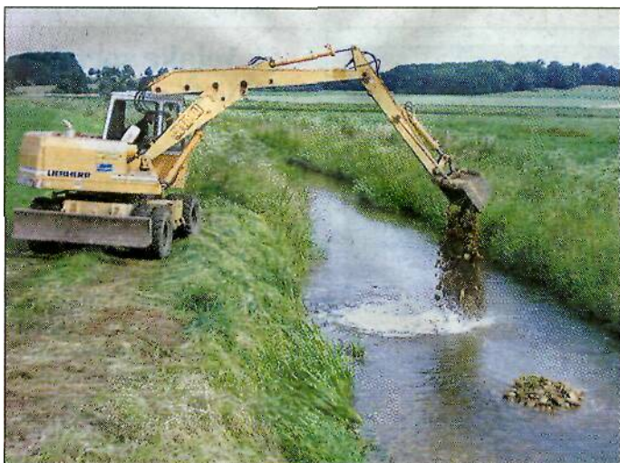
Der Angel- und Gewässerschutzverein in Aktion: 50 Tonnen Kies sollen die Struktur der Schunter verbessern.
