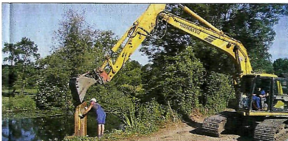
Bagger im Einsatz: Am Mühlengraben entsteht ein Durchlass
